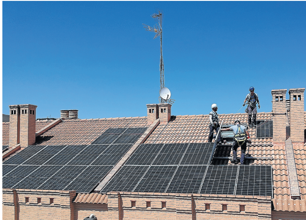
La empresa zaragozana Efitar Ingeniería monta una instalación fotovoltaica en una vivienda. HA
